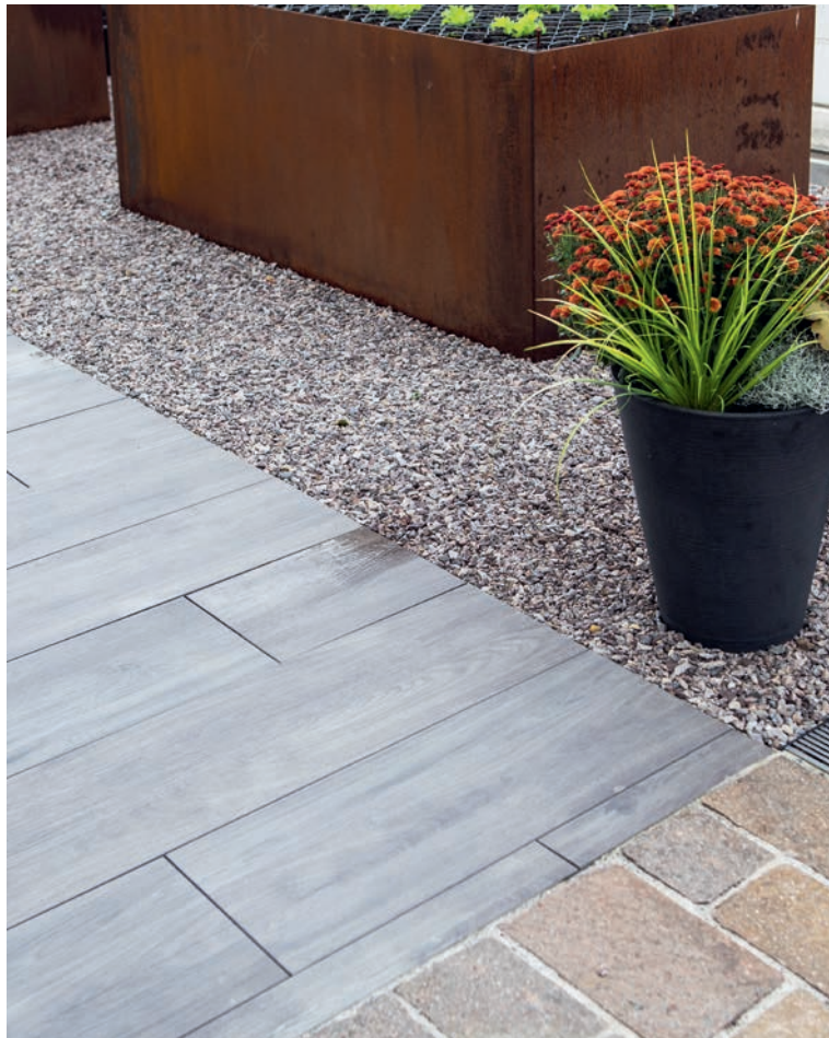
Belagswechsel mit unterschiedlichen Gleitfestigkeiten weisen ein höheres Gefahrenpotenzial auf.
