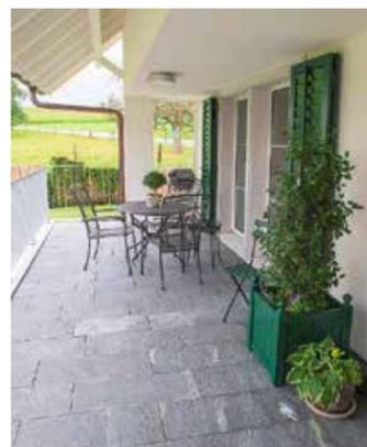
Links: Bodenbeläge bei überdachten Sitzplätzen sind Feuchte und Nässe weniger stark ausgesetzt und somit schon dadurch trittsicherer. Rechts: Rauere Plattenoberflächen machen den Wechsel vom überdeckten zum ungedeckten Sitzplatz respektive von trockenen in nasse Zonen trittsicherer.
