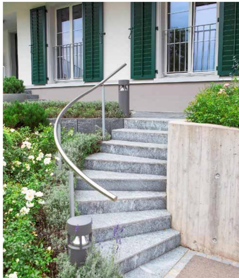
Treppenstufen verbinden verschiedene Ebenen miteinander und sollten rutschhemmend und trittsicher ausgeführt sein. Geländer und Handlauf erhöhen die Sicherheit zusätzlich.
