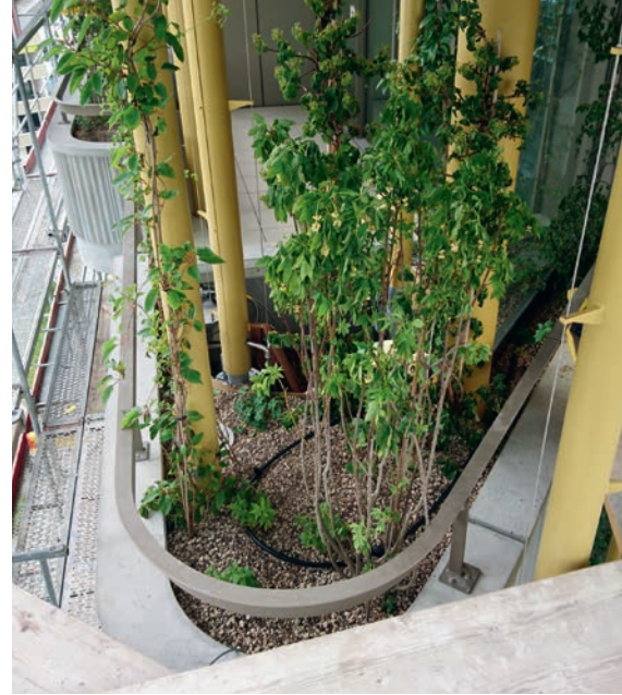
Diejenigen Säulen, die nicht der Statik dienen, kommen beim Gartenhochhaus als Kletterhilfen zum Einsatz. Foto: Lorenz Eugster Landschaftsarchitektur und Städtebau GmbH
