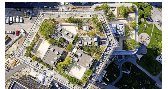
Blick von oben: 6 bis 7 m hohe Gehölze und eine abwechslungsreiche Staudenunterbepflanzung sorgen demnächst für ein üppiges Pflanzenbild.
