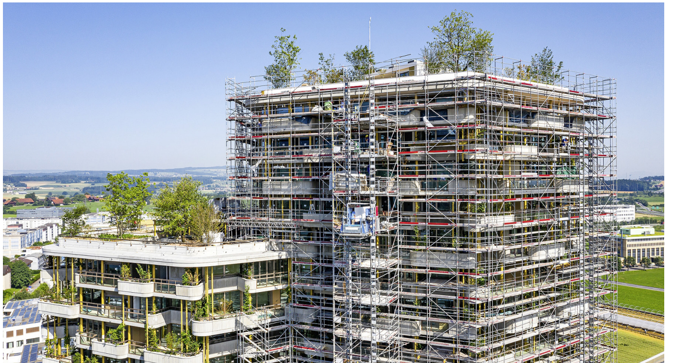
Am 70 Meter hohen Gartenhochhaus werden auf einer Fläche von 1580 m 2 über 15 000 Gehölze und Stauden angebracht. Dafür braucht es rund 1300 m 3 Substrat.
