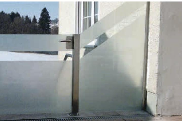
Oben: Edelstahlsteher mit Sicherheitsglas, eine passende Sonderanfertigung
