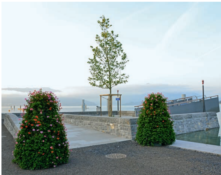
Neu erstellte Schiffsstation mit Natursteinverkleidung aus Guber-Steinen
