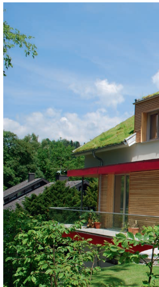
Schrägdachbegrünungen erfordern spezielle Begrünungssysteme.
