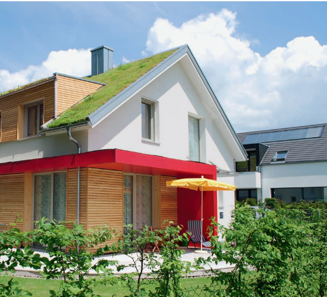
Unten: Kombiniert mit einer extensiven Dachbegrünung erzielen Solarpanels einen höheren Wirkungsgrad.
