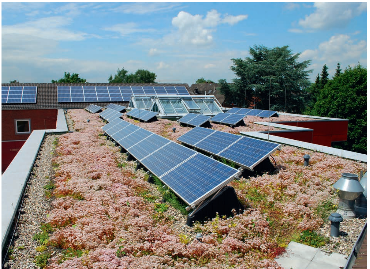
Unten: Kombiniert mit einer extensiven Dachbegrünung erzielen Solarpanels einen höheren Wirkungsgrad.
