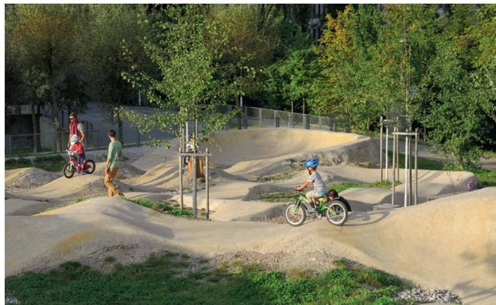
Idealerweise werden sie nicht in den Boden eingegraben, sondern über dem Areal aufgehäuft. So kann das Wasser abfließen und ohne zusätzliche Drainage versickern. Grössere Anlagen können auch auf einem Kieskoffer erstellt werden, damit das Wasser flächig versickern kann.
